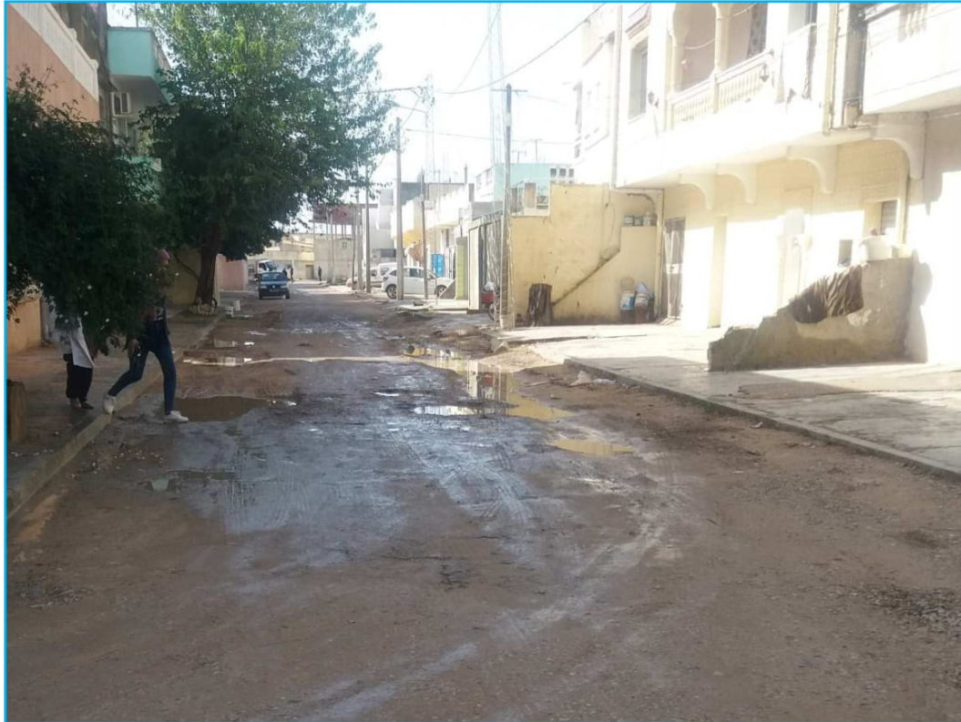
Stagnation importante des eaux pluviales
