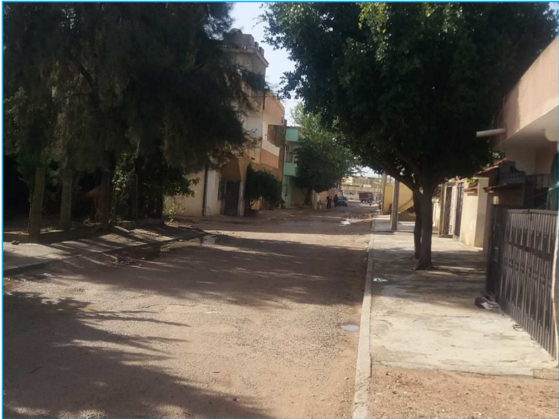
Voie en état dégradé
